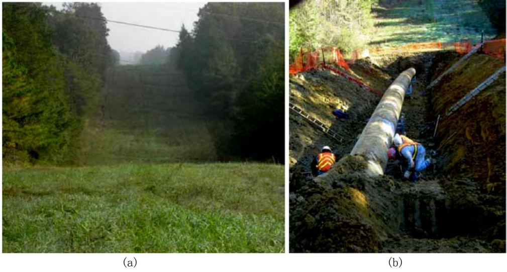
图10: 现场#1 (a) 开挖前 (b) 开挖后
