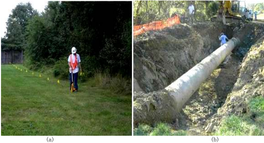
图 13: 现场#3, 第二次开挖(a) 检测中 (b) 开挖后
