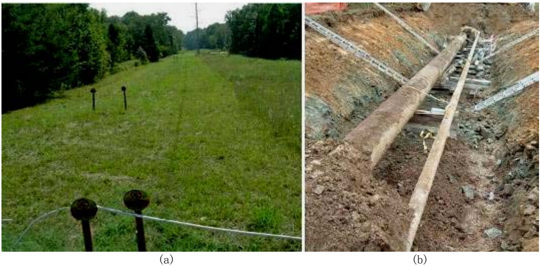
图12: 现场#3, 第一次开挖(a) 检测中 (b) 开挖后
